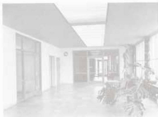
Abb. 9. Flur mit eingebauten Nebenschleife.
