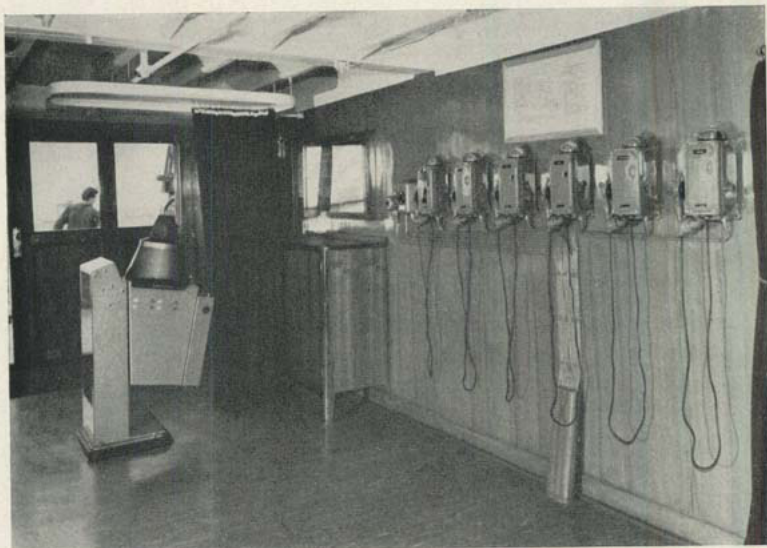
BILD 356 Kommandobrücke eines modernen Turbinen-Schnelldampfers mit 6 batterielosen Fernsprech-Wandapparaten
