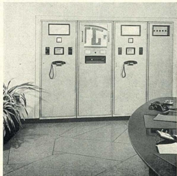
Melde- und Empfangseinrichtung für 2 kombinierte Feuermelde- und Wächterkontrollschleifen mit 2 Lageplantagebläusen und Überwachungszentrale für die Polizei-Notruf-Anlage
