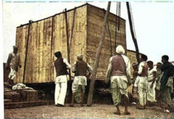
Abladen eines Großbehälters („Liftvan“) mit primitiven Hebezeugen.
