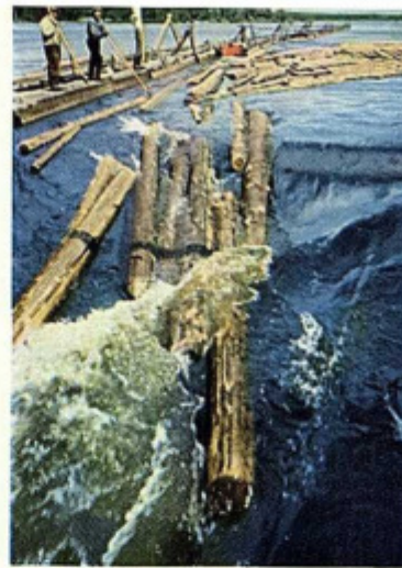
Staustufe mit Holzrutsche für Baumstämme
