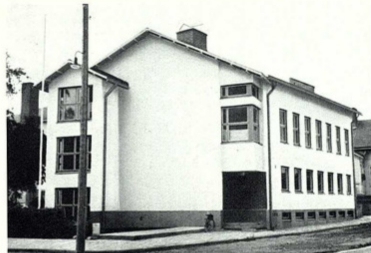
Hauptamtsgebäude Vammala mit TuN-Wählamt für 800 Teilnehmer
