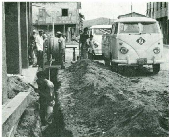
BILD 2 und 3 Einheimische Monteure bei der Verlegung von Kabeln für ein Ortsnetz in Ecuador
