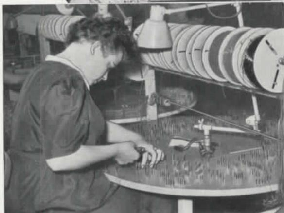
An diesen Drehtischen entstehen gleichzeitig jeweils 6 Kabelbäumchen für die Innenverkabelung der Telefonapparate
