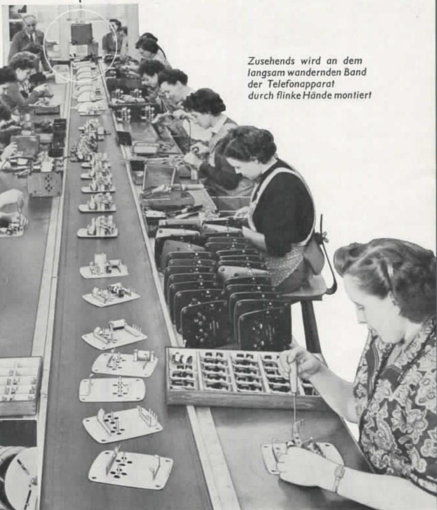
Zusehends wird an dem langsam wandernden Band der Telefonapparat durch flinke Hände montiert
